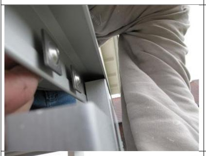
✓ Balkonprofile zuerst nach unten in Gleitmutter einfädeln, danach Profile in Aluminium Regenleiste nach oben einschieben...
