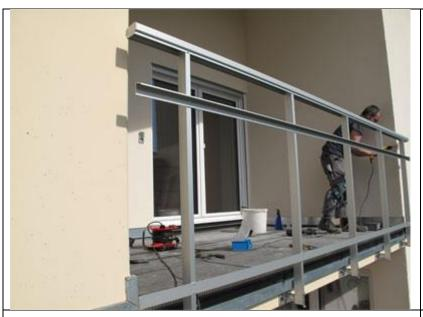
Nachdem das Geländer-System hergestellt wurde können nun mittels einer Schablone die Bohrungen für die obere Querblende an den Pfosten angezeichnet werden.
