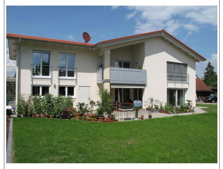
Bei dieser Montage wurde Balkonprofil Nr. 6000 in Dekor "Metallic" verwendet. Der Zwischenabstand der Profile beträgt 2 cm, d.h. 6 Profile pro Meter.
