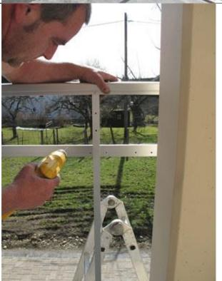
✓ Bohrungen für M6 Zylinderkopfschrauben mit Durchmesser 6,5 mm ausführen
