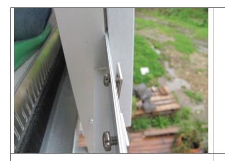
✓ Gleitmutter Artikel-Nr. 9001 mit M6-Gewinde und Edelstahl Zylinderkopfschraube M6x12mm locker zusammenschrauben.
