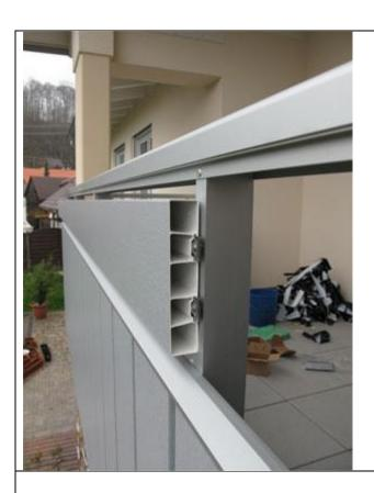
Zum Schluss wird obere Blende in Gleitmuttern eingefädelt und fixiert. Danach Abdeckkappen mit Spezial-Kleber, Artikel-Nr. 9090 verkleben.
