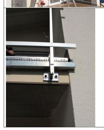
✓ Anzeichnen/Bohren/Vernieten der Doppel-Gleitmutter für die untere horizontale/waagerechte Blende.
