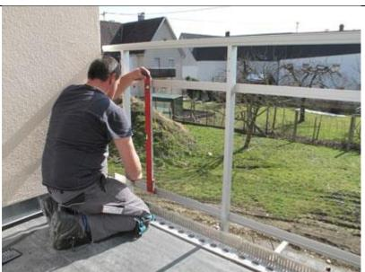
Mit einer Wasserwaage mit entsprechendem Zwischenabstand (2 cm) können nun die vertikalen/senkrechten Bohrungen angezeichnet werden.
